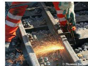
Bild vergrößern Vorbereiten der Lücke durch Schneidbrennen
