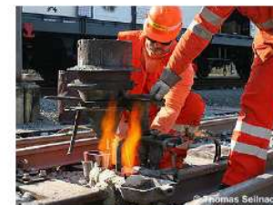
Bild vergrößern Vorheizen der Schienen
