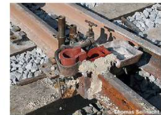
Bild vergrößern Anbringen der Verschalung
